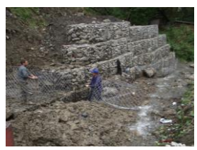
תשע"ג: ספעציעלע גאביאנס (Gabions) געבויעט צו אפזינגלען דעם בארג
