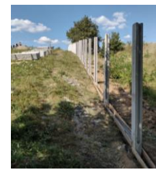
פארשריט אויפ'ן גדר: די יסודות און פאנעלן ווערן אריינגעלייגט
