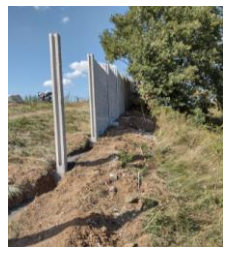
פארשריט אויפ'ן גדר: די יסודות און פאנעלן ווערן אריינגעלייגט
