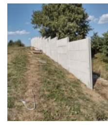
פארשריט אויפ'ן גדר: די יסודות און פאנעלן ווערן אריינגעלייגט
